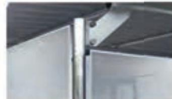
Parois en tôle percée, trous de Ø 3mm. Transparents ou opaques en fonction de l'angle de vision.
